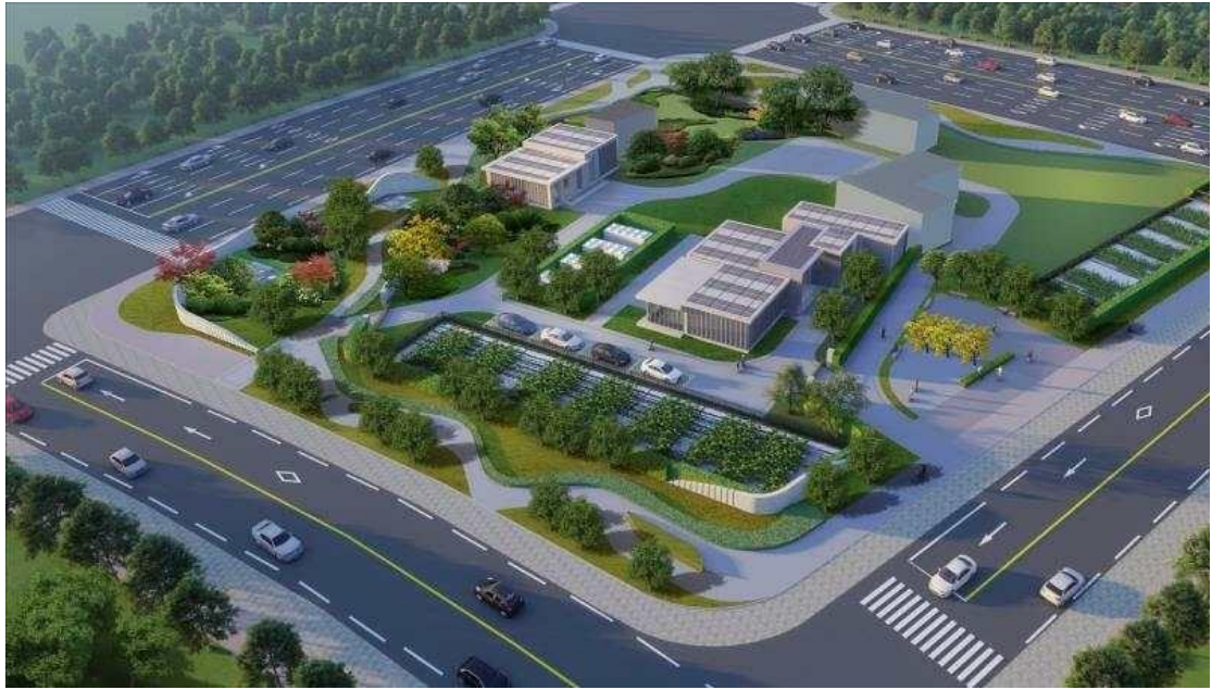
图 11 雄安新区容东片区供热（冷）建设运营服务项目
