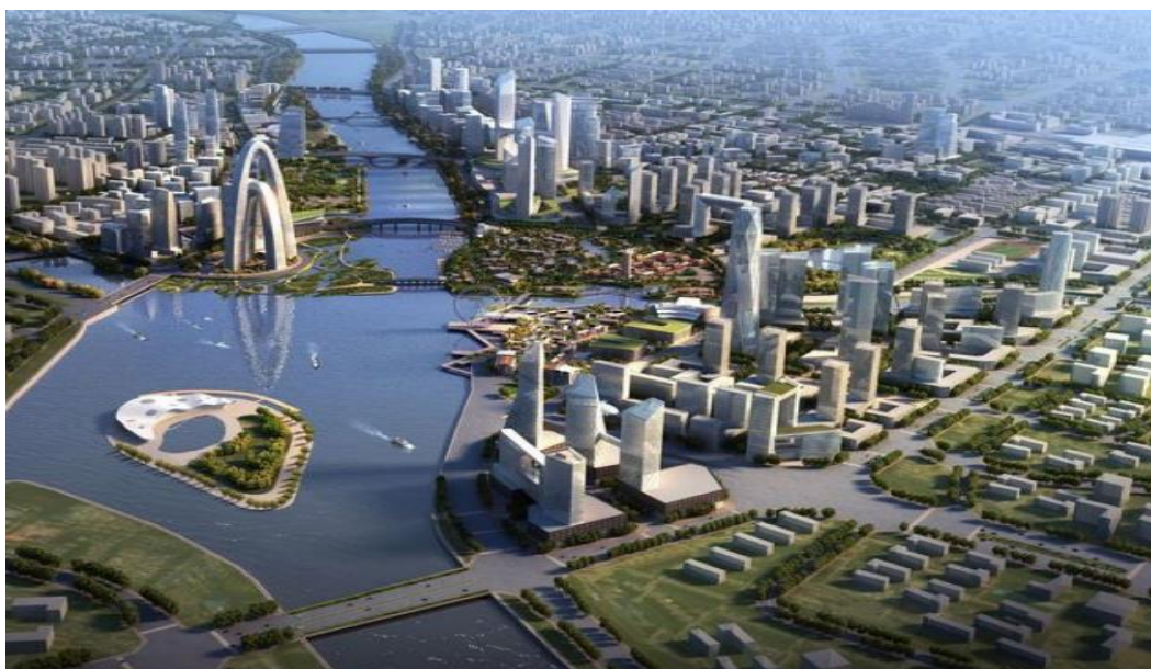
图 42 北京城市副中心区域“多能协同、智能耦合”项目
