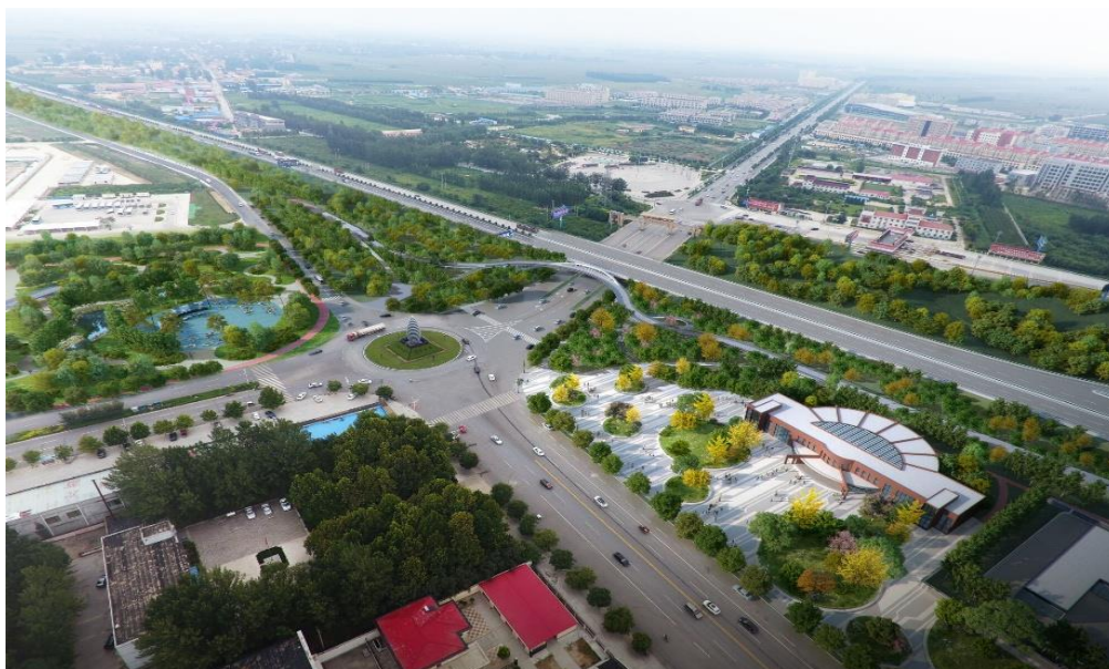
图 10 容城容东片区截洪渠一期工程
