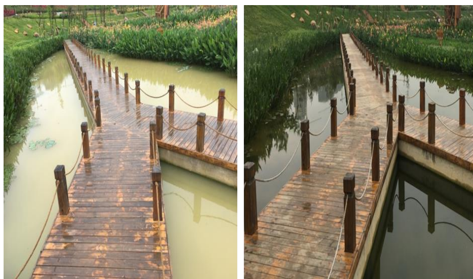
图 50 河道底泥原位修复前后对比
