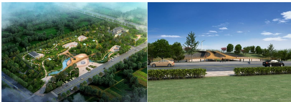
图 68 新航城东区再生水厂（一期）工程
