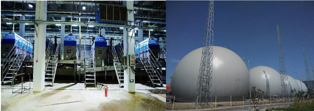
图 66 槐房再生水厂实景图
