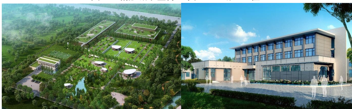
图 69 新航城西区再生水厂（一期）工程
