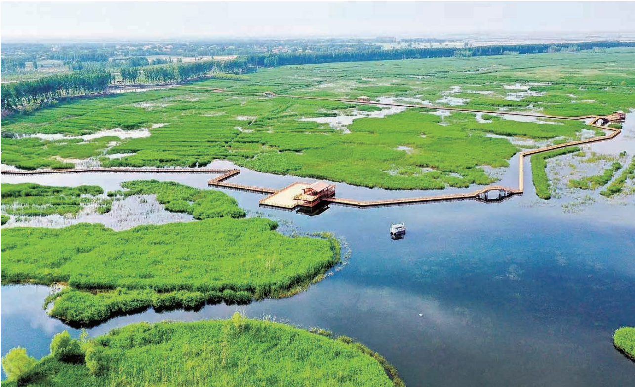
北燃实业设计监理公司监理的白洋淀重点村落（安新县）隐性污染源治理项目
