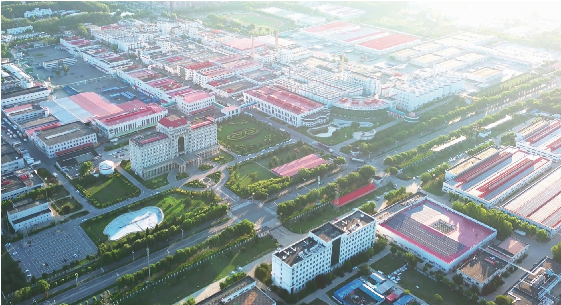
燕京啤酒科技大厦及生物科技园
