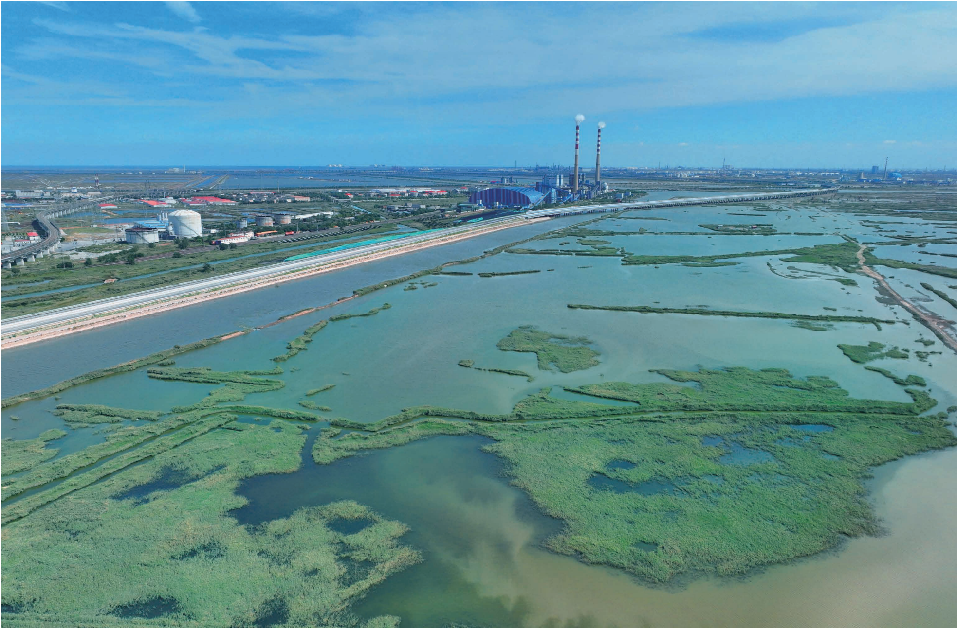
北京燃气天津南港液化LNG应急储备项目管线穿越北大港湿地恢复原地貌
