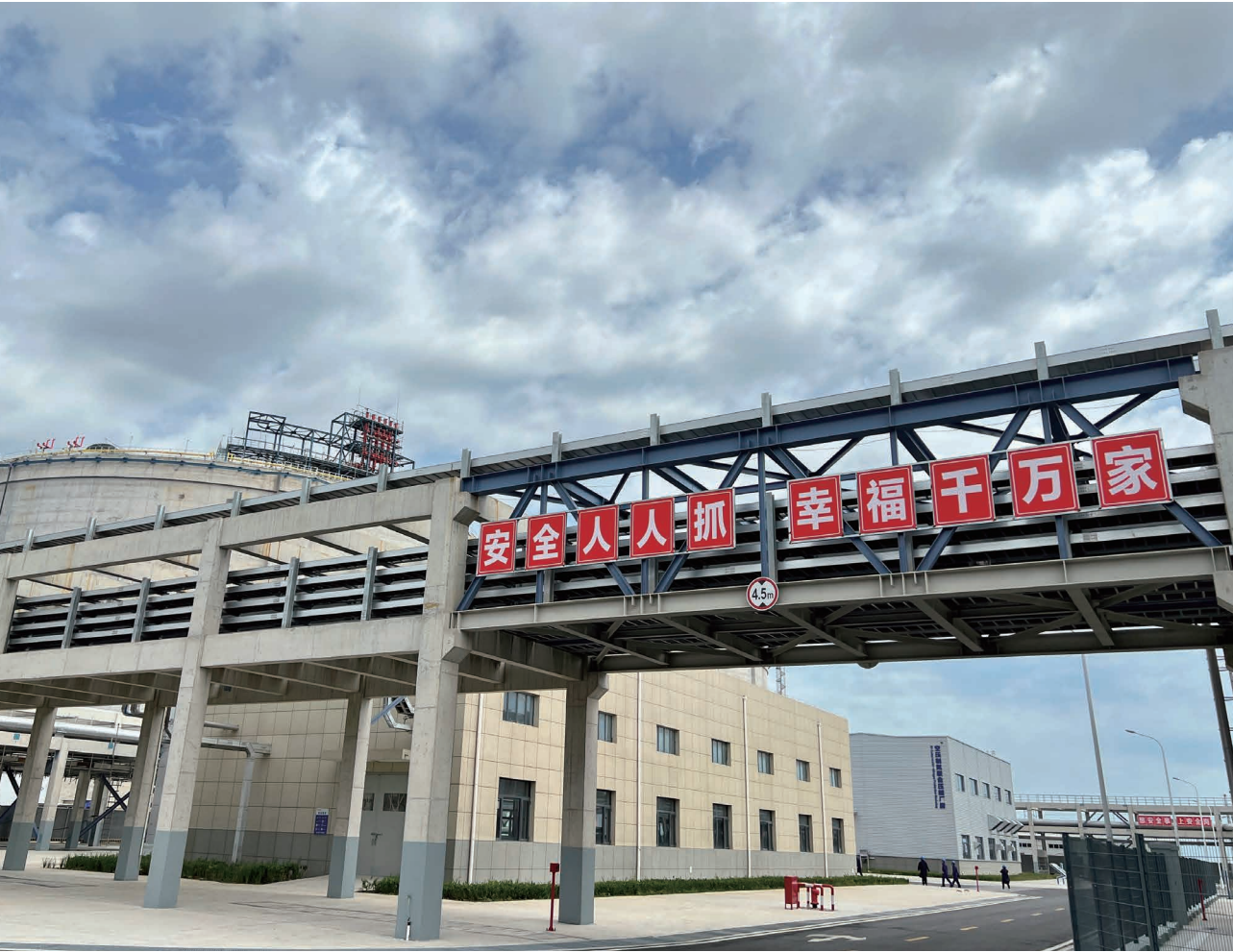
北京燃气天津南港LNG应急储备项目高度重视安全管理
