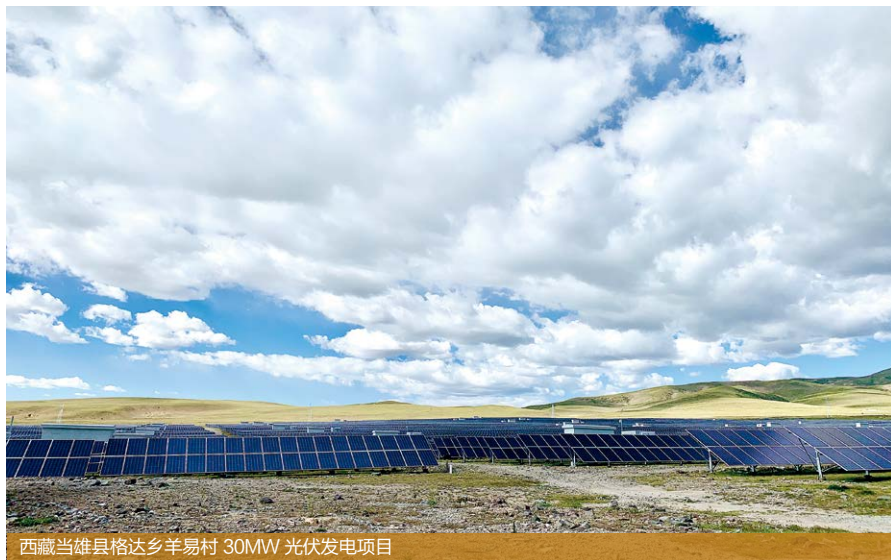
西藏当雄县格达乡羊易村 30MW 光伏发电项目
