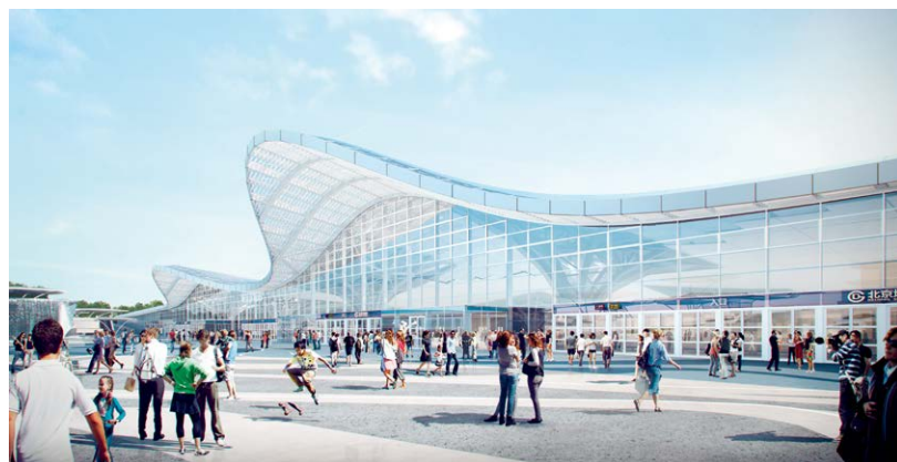
■ 北京地铁7号线延长线环球影城站： 获《工程新闻记录》(ENR)全球优秀项目奖。
