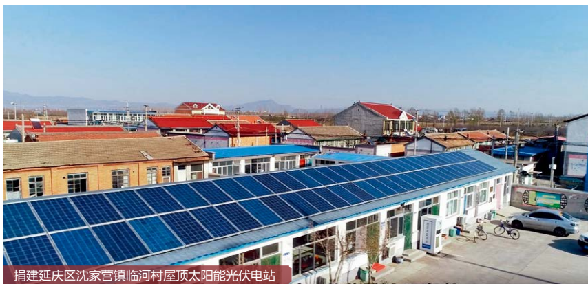
捐建延庆区沈家营镇临河村屋顶太阳能光伏电站
