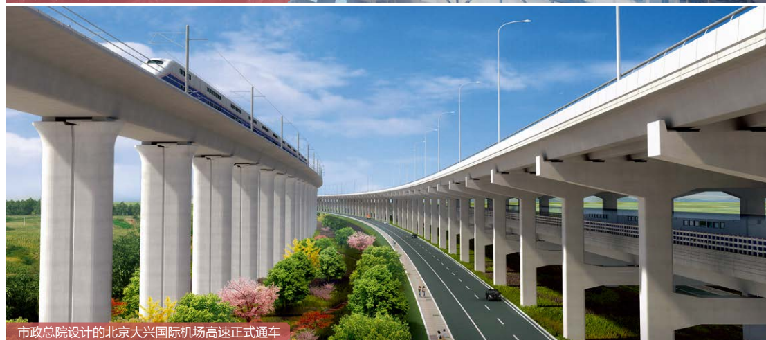
市政总院设计的北京大兴国际机场高速正式通车
